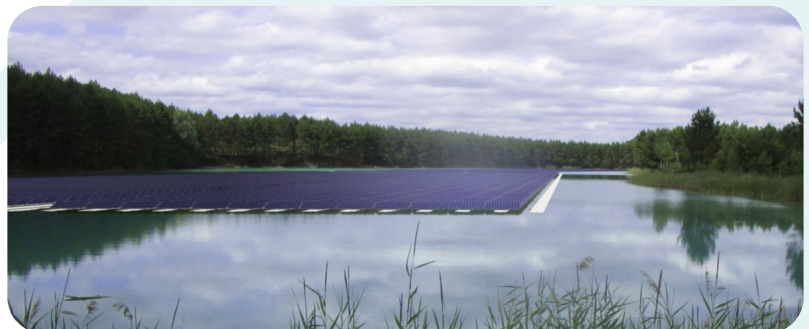
Figure 3 : Centrale solaire flottante de Durance
