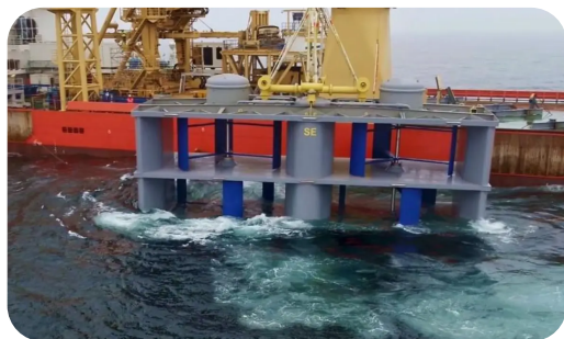
Figure 3 : Hydrolienne Hydroquest à flux transverse à embase gravitaire
