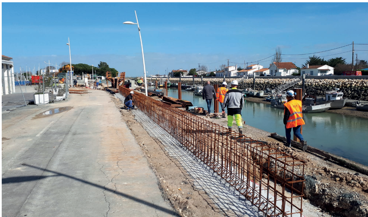
Travaux d'endiguement en 2021 sur le chenal de Boyardville. À l'arrière, plusieurs maisons submergées lors de la tempête Xynthia ont été démolies © CCIO
