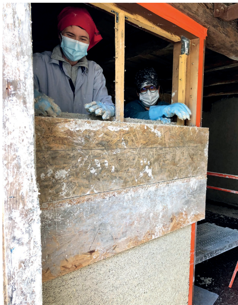
Formation écomatériaux : cloison chaux-chanvre.
